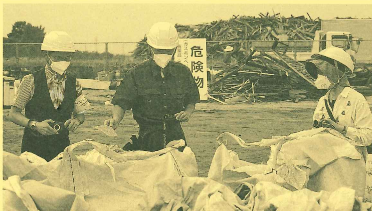
熊本地震の廃棄物仮処分場でアスベスト調査
